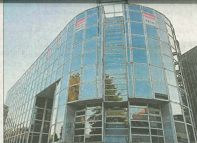
La Ville est déjà propriétaire du rez-de-chaussée, des deuxième, troisième et maintenant quatrième étages de l'espace Ceve de Voiron. Photo Le DL/Marine LANGEVIN
